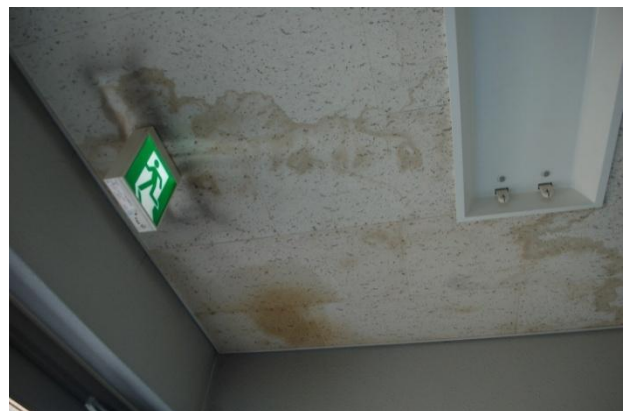
上階の窓から入った雨水が伝い天井内に滞水したと考えられる1階非常出口の天井
