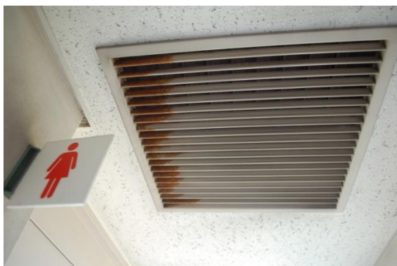
天井換気口に見られるサビ
