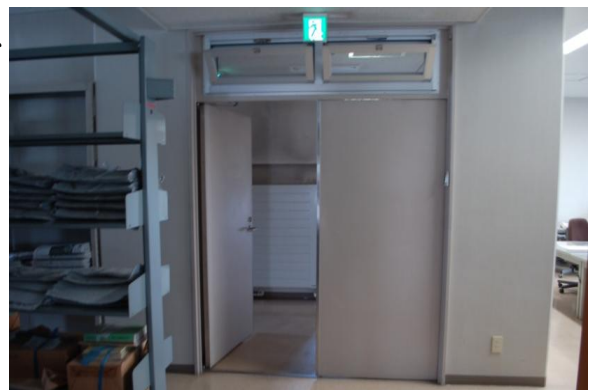
4階東側非常通路部分と防火戸
