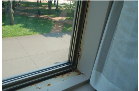
下階の窓枠のサビ
